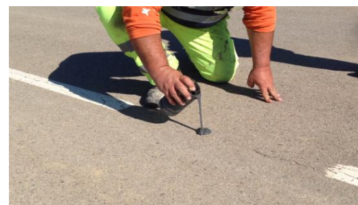
6- Verter dosificación en punto de colocación
